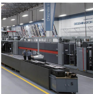
Centro de distribuição
